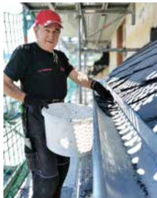
Schieferarbeit in Vollendung auf dem Dach des denkmalgeschützten Weinguts.
